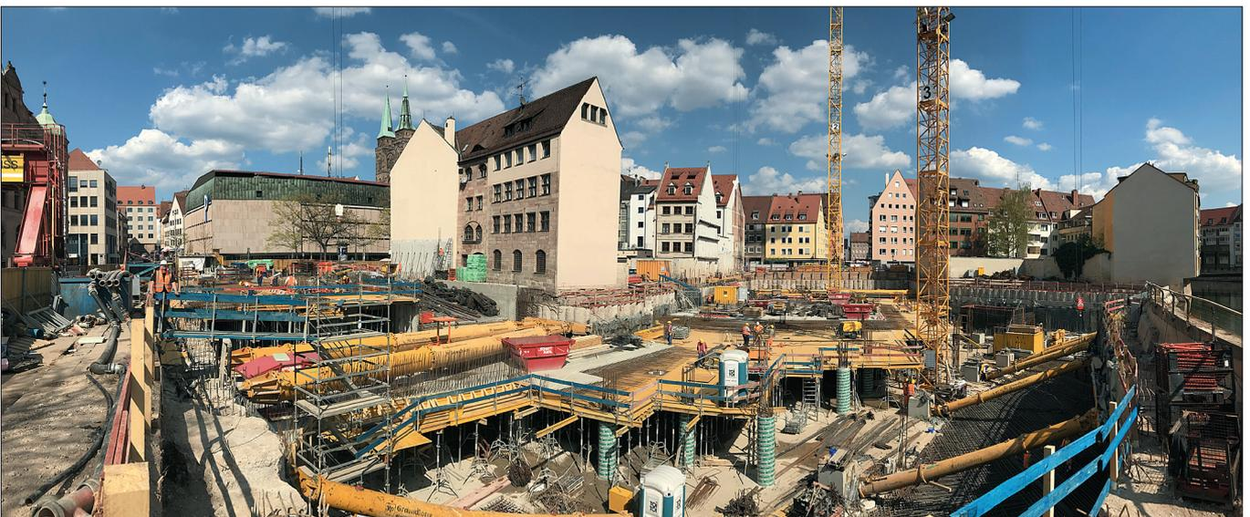
Durch umliegende Brunnen wurde das Grundwasser so weit abgesenkt, dass die tiefste Stelle der Baugrube 11 m unter dem Wasserlevel der Pegnitz lag.
