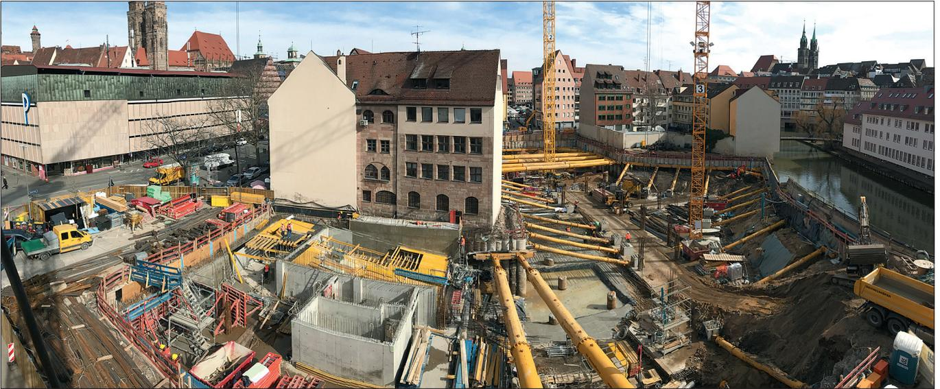
Die pegnitznahe Lage und die umliegende denkmalgeschützte Bebauung erforderten eine Aussteifung der Baugrube nach innen.
