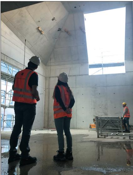
Durch die gleichen Schalungselemente für Wände und Dach entsteht eine einheitliche, optisch verbindende Struktur.
