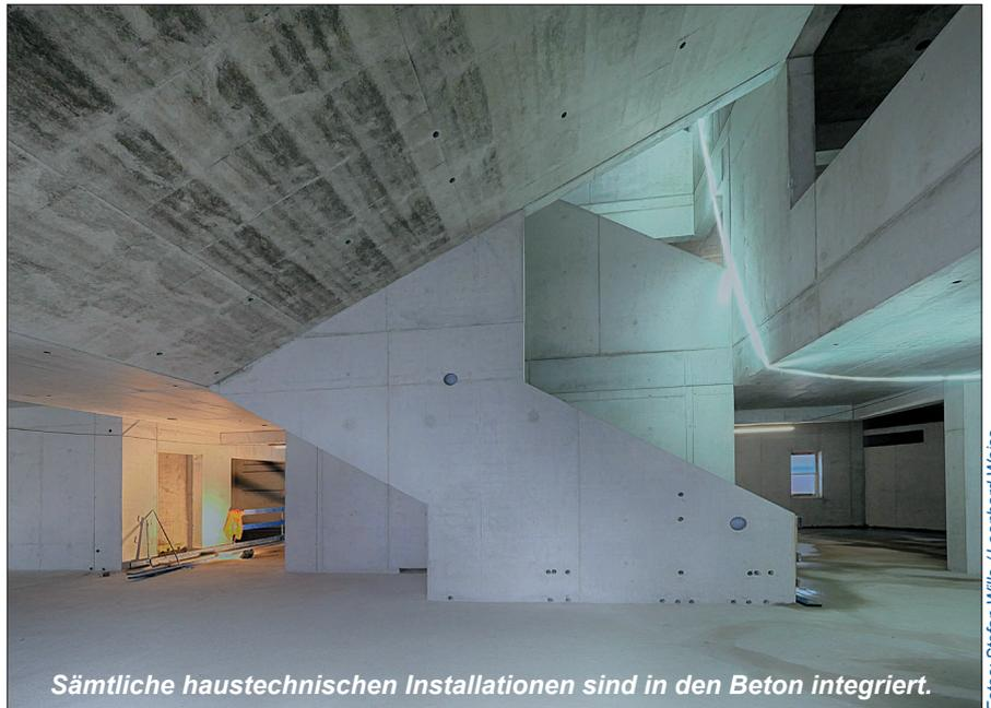
Sämtliche haustechnischen Installationen sind in den Beton integriert.
