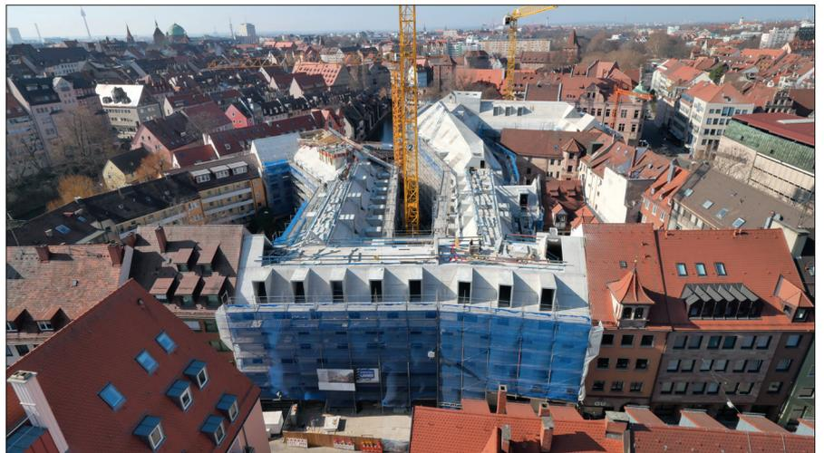
*Die unregelmäßige Form des Sichtbetondachs konnte Leonhard Weiss mithilfe von 3D-Visualisierungen, BIM und einer unkonventionellen Schalungstechnik umsetzen.*
