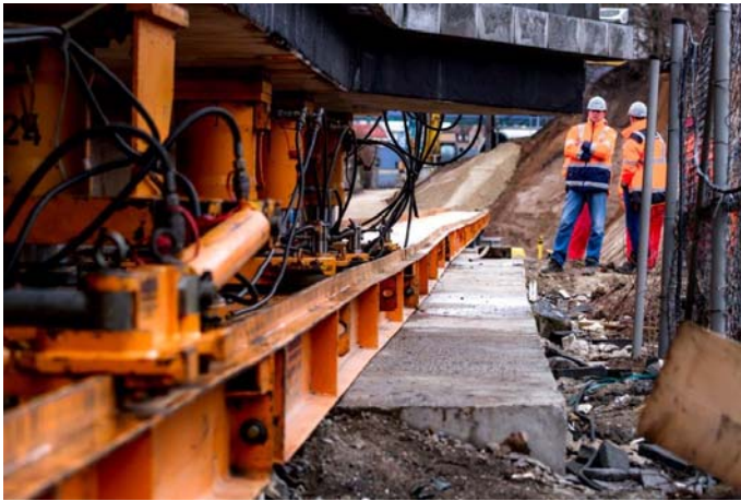
Je Seite setzten die Mitarbeiter acht Pressen mit einer jeweiligen Traglast von 250 t unter das Bauwerk und verschraubten sie. Unter die Pressen wurde Stickstoff mit einem Druck von 26 bar geleitet, so dass das Bauwerk wie auf einem Luftpolster in seinen Fahrinnen gleiten konnte. © LEONHARD WEISS
