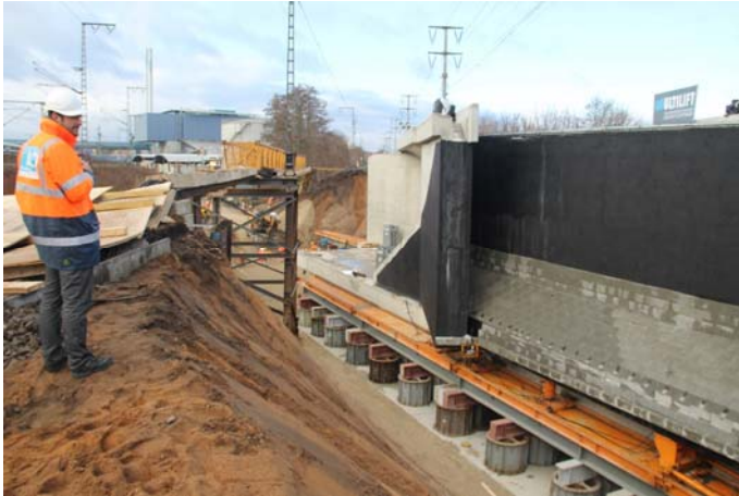
Im tieferen Teil der Baugrube unterfütterten Stapel die Verschubbahnen und glichen so den Höhenunterschied aus. © DB AG/Hannes Frank
