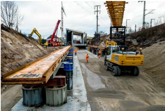
Mit Hilfe weiterer, von hinten schiebender Pressen sollte das Bauwerk auf den Verschubbahnen eine Strecke von 70 m zurücklegen. © LEONHARD WEISS
