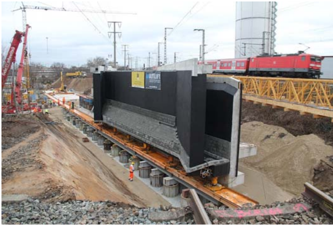
Nach eineinhalb Stunden stand die neue Kreuzung schon an ihrem Platz – allerdings noch 2,13 m zu hoch. © DB AG/Hannes Frank
