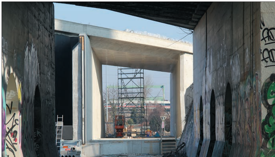
Aufgrund der extrem kurzen Vollsperrung der Bahnlinie von nur einer Woche baute LEONHARD WEISS das neue Nürnberger Kreuzungsbauwerk schon vorab direkt neben der Strecke.
