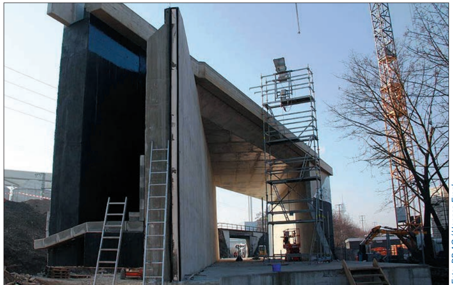
Innerhalb von sechs Monaten entstand ein über 8 m hohes, 12 m breites und 35 m langes Kreuzungsbauwerk aus Stahlbeton mit einem Gewicht von mehr als 3.200 t.
