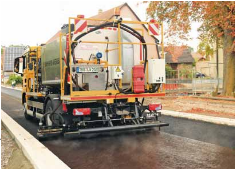
Für die Naht- und Randversiegelung mit Bitumen ist das Fahrzeug mit einem Aufsatz-Rührwerkskocher mit 500 kg Nutzinhalt ausgestattet.
