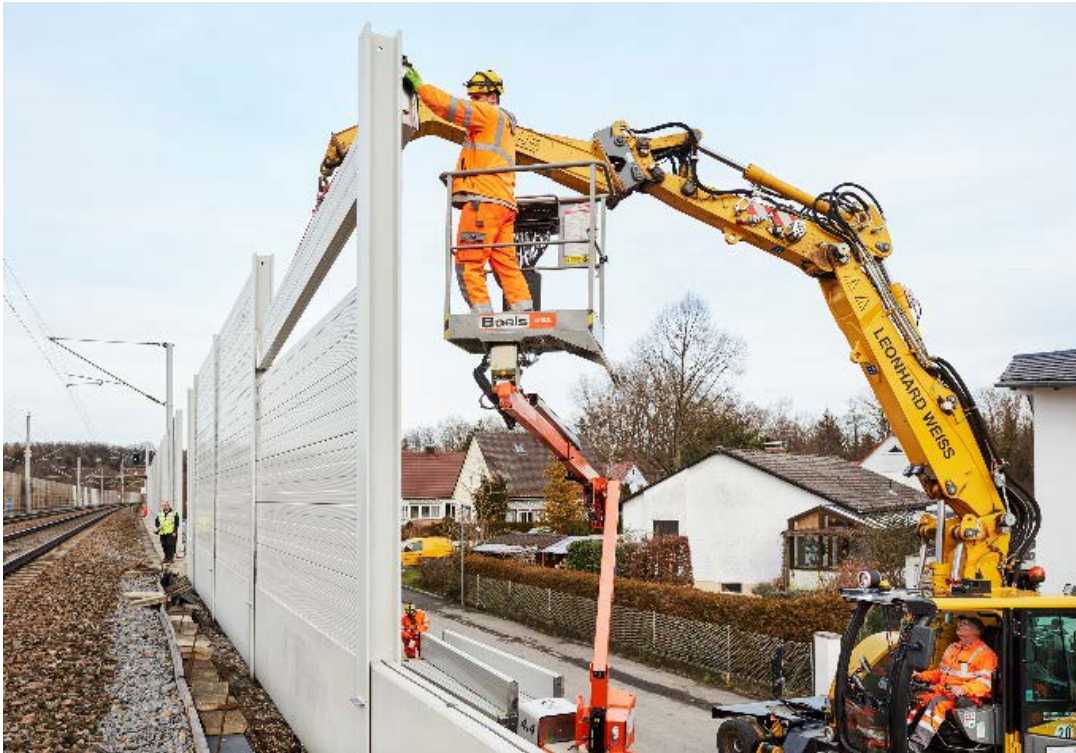
Einbau eines Aluminium-Lärmschutzelements von außen mit einem Zweibeinbagger
