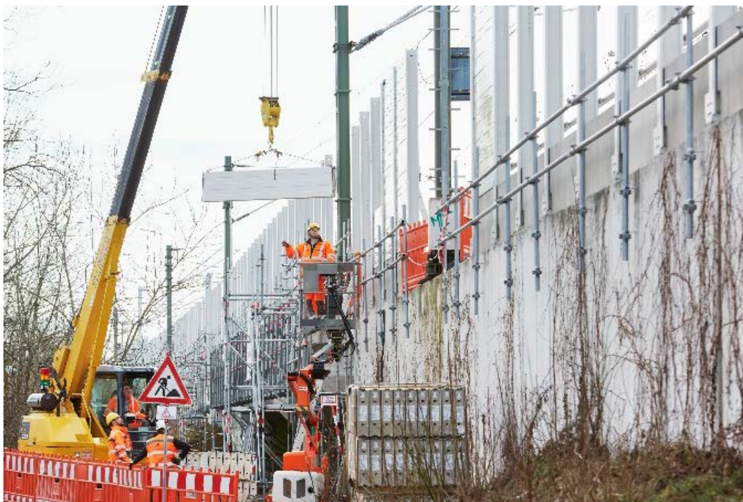
Montage der Lärmschutzwand mit einem Kettenkran auf einer Stützmauer
