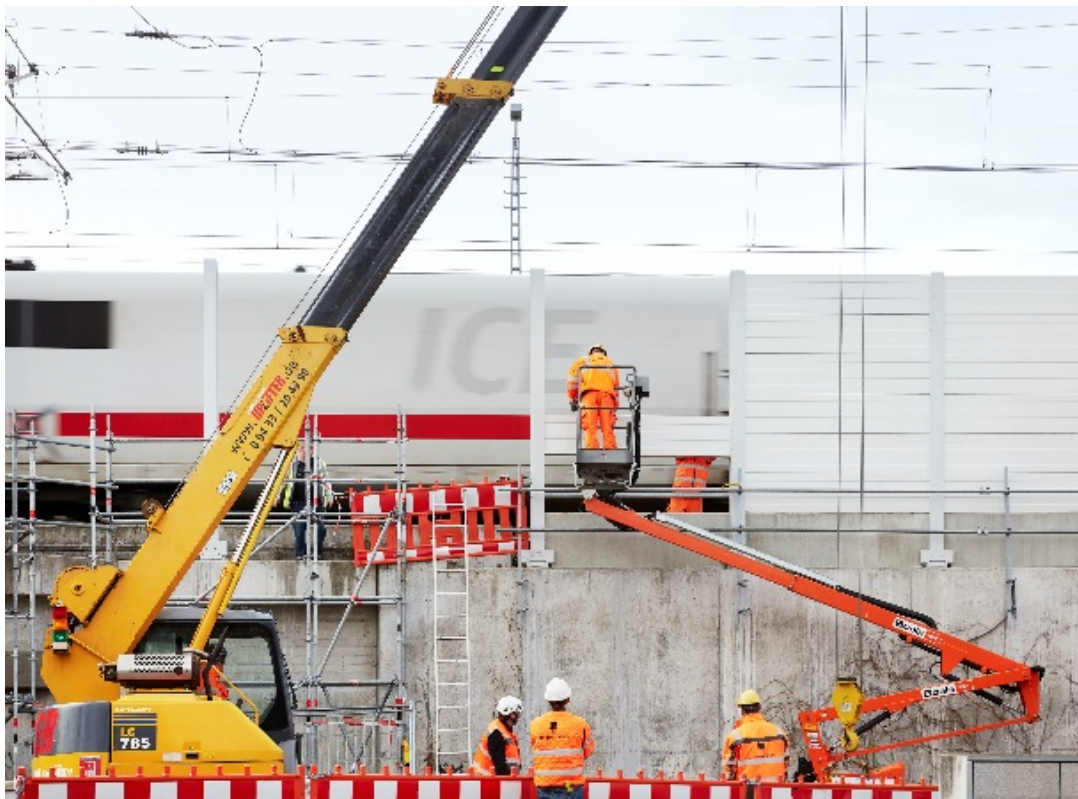
Arbeiten unter rollendem Rad auf der Strecke Obermenzing – Röhrmoos
