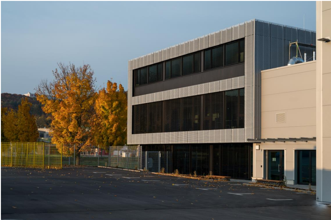
Der Neubau mit Streckmetallfassade und bodentiefen Fenstern. (Bilder: Markus Jokisch, www.asphaltmann.de )
