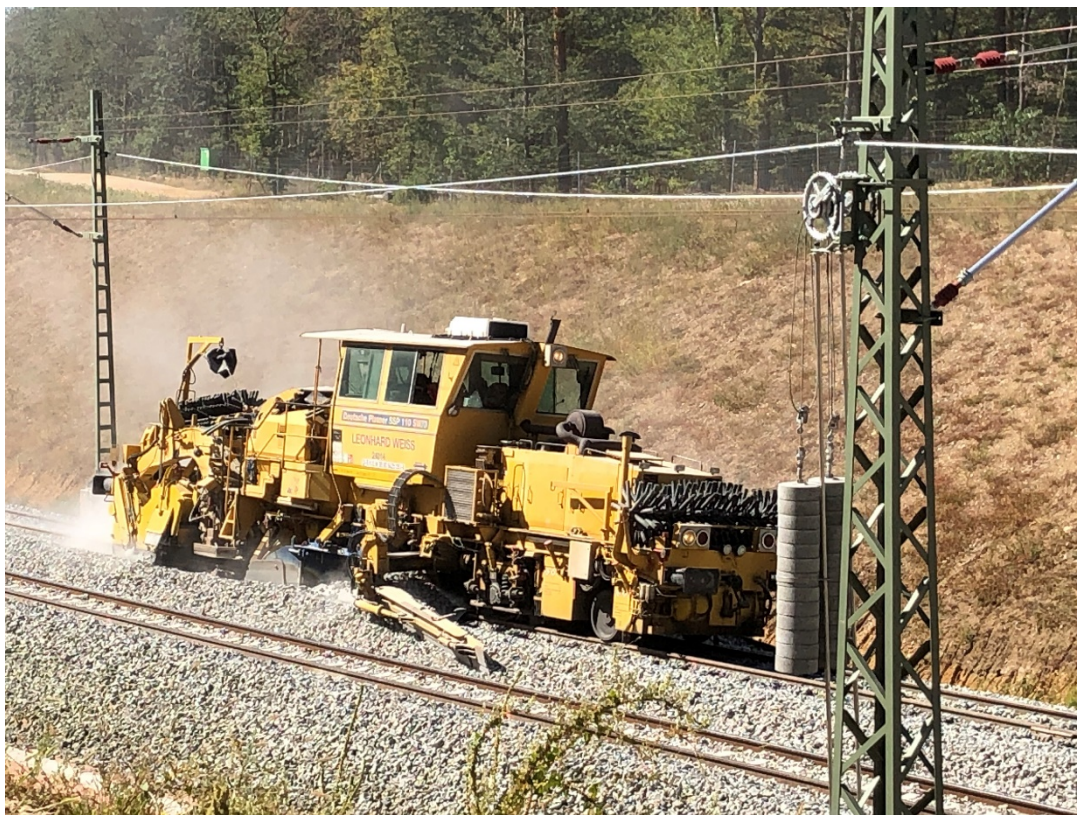
Schotterplaniermaschine mit eingebautem Kollisionswarnsystem im Einsatz Bild: LEONHARD WEISS
