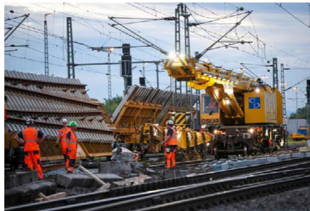
**Abb. 6 u. 7:** Weicheneinbau mittels Weichentransportwagen (WTW, linkes Foto) und Eisenbahndrehkran (EDK)
