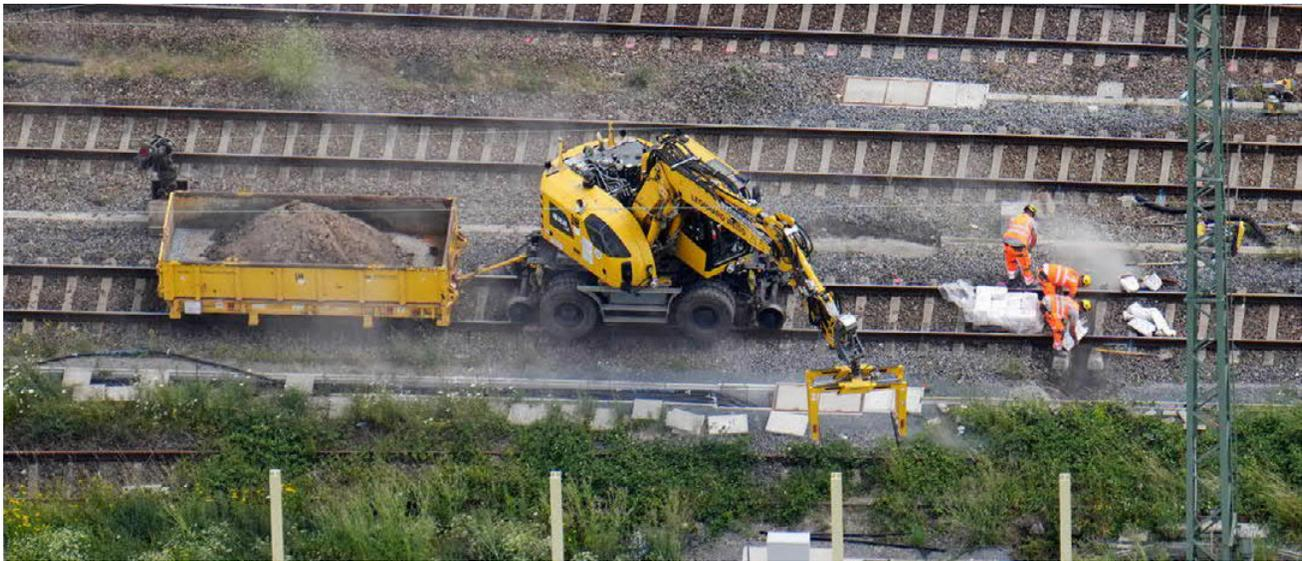
Abb 2: Kabeltiefbauarbeiten auf der Strecke
