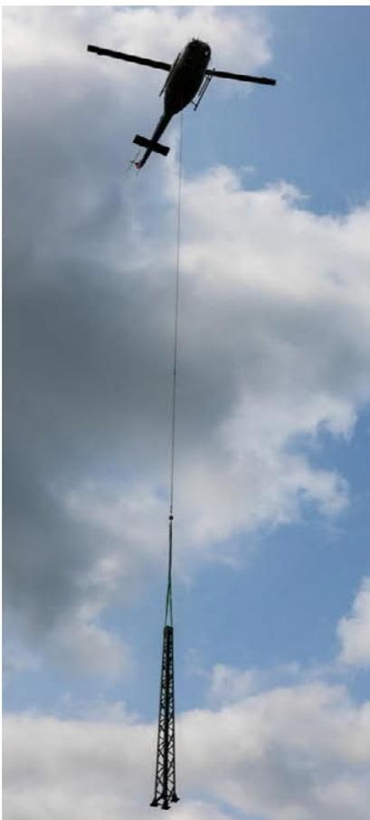
**Abb. 10:** Transport von Stahlmasten mittels Helikopter
