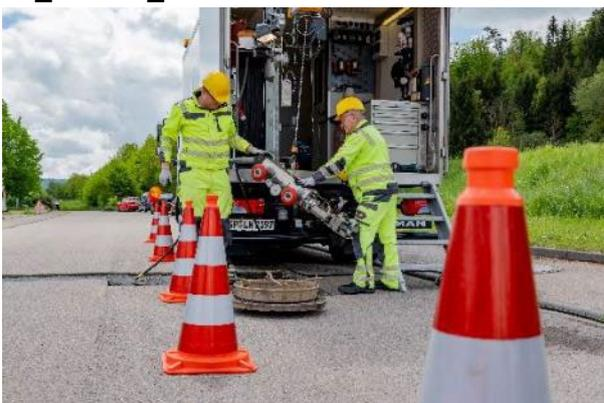
Bagger oder anderes schweres Gerät sucht man bei den mit FAST durchgeführten Glasfaser-Verlegearbeiten vergeblich, denn aufwendige Tiefbaumaßnahmen entfallen bei dieser Methode.
