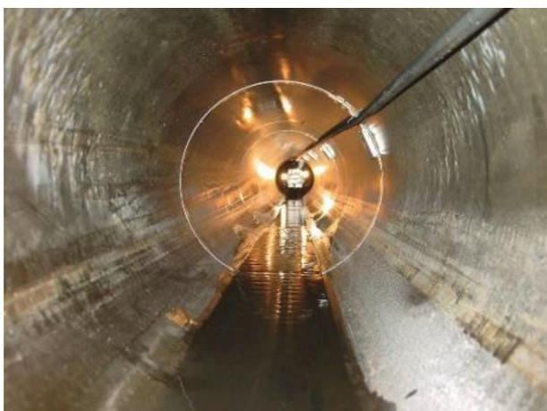
Der Roboter verlegt an der Rohrwandung sogenannte Innenbriden, die zur Aufnahme der FAST-Leerrohre dienen.
