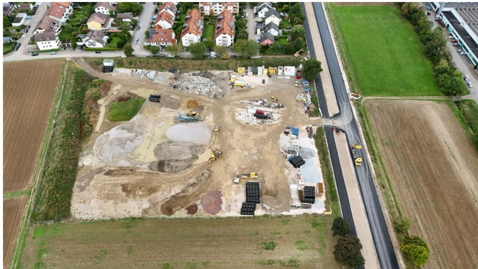
Durch in-Situ-Beprobungen haben wir die umwelttechnischen Eigenschaften des Materials geprüft und Einbauorte gemäß Ersatzbaustoffverordnung festgelegt. Dabei wurden Grundwasserabstand und Untergrundbeschaffenheit berücksichtigt, sodass der zukünftige Einbauort bereits vor dem Ausbau definiert werden konnte.
