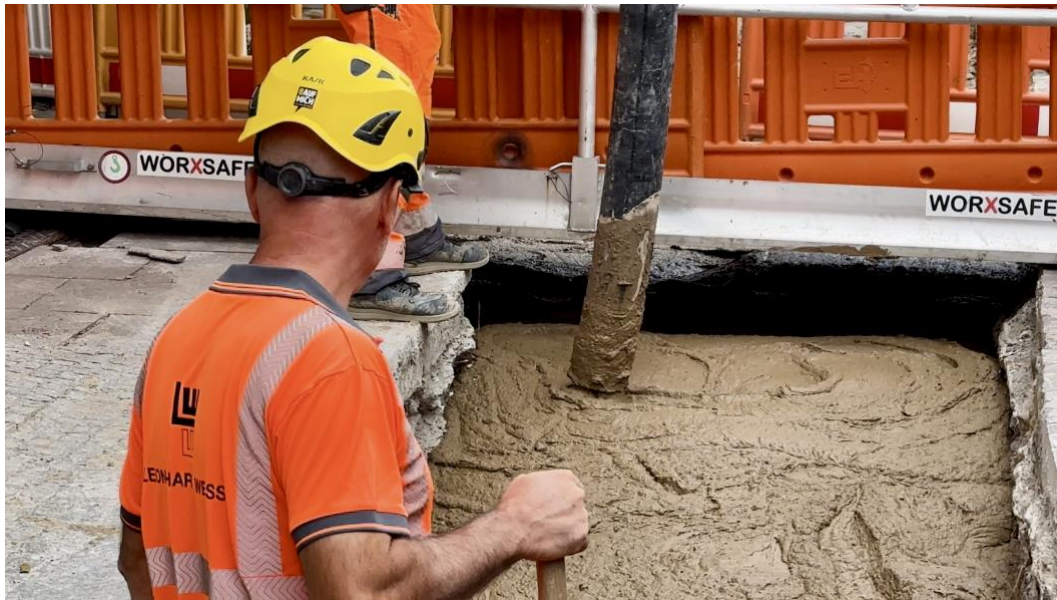
Der Flüssigboden wird auf der Baustelle in Sindelfingen verfüllt. Foto: LEONHARD WEISS
