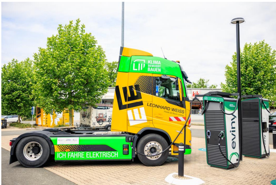
Der fertiggestellte Ladepark in Fürth. Foto: LEONHARD WEISS
