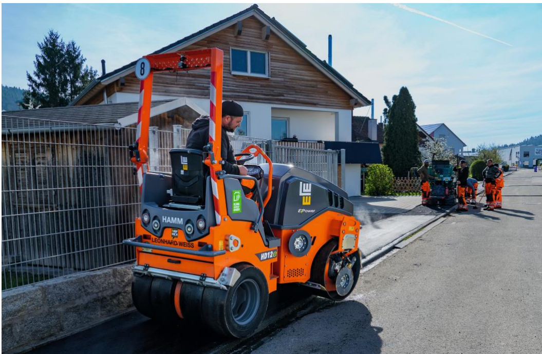
Rangendingen E-Asphaltwalze. Foto: Wirtgen
