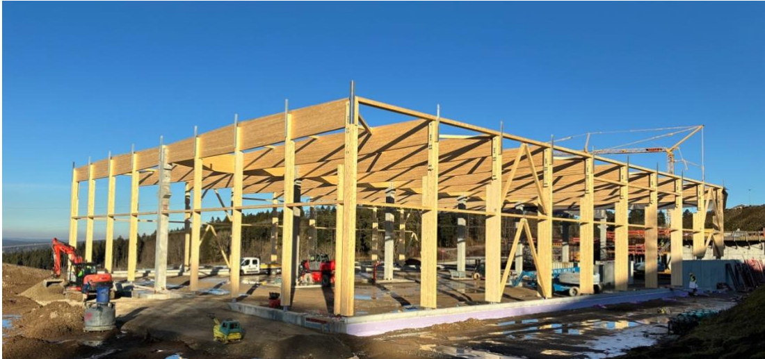
Schlanke Stützen entlang der Fassade tragen das 22 m gespannte Satteldach und dienen als Auflager für den Hallenkran. Foto: LEONHARD WEISS
