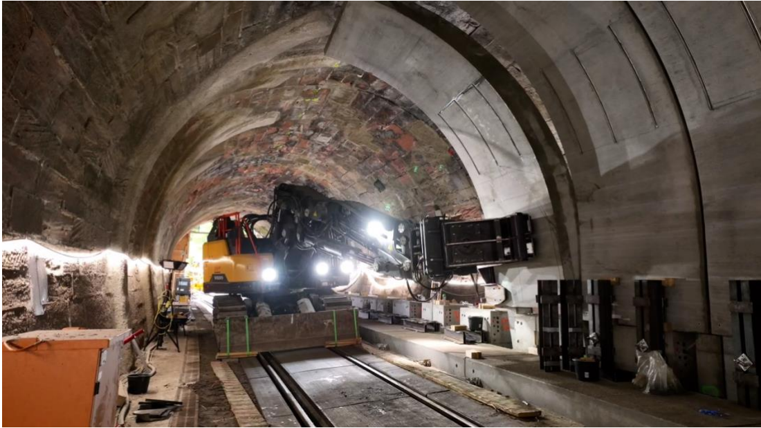
Das Greifersystem im Tunnel der Bahnstrecke Calw-Weil der Stadt. Foto: LEONHARD WEISS
