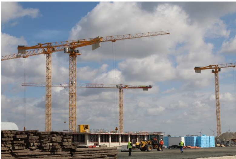
Das Baufeld der neuen Zentralklinik Ostfriesische Meere. Foto: Trägergesellschaft (Rechteinhaber)
