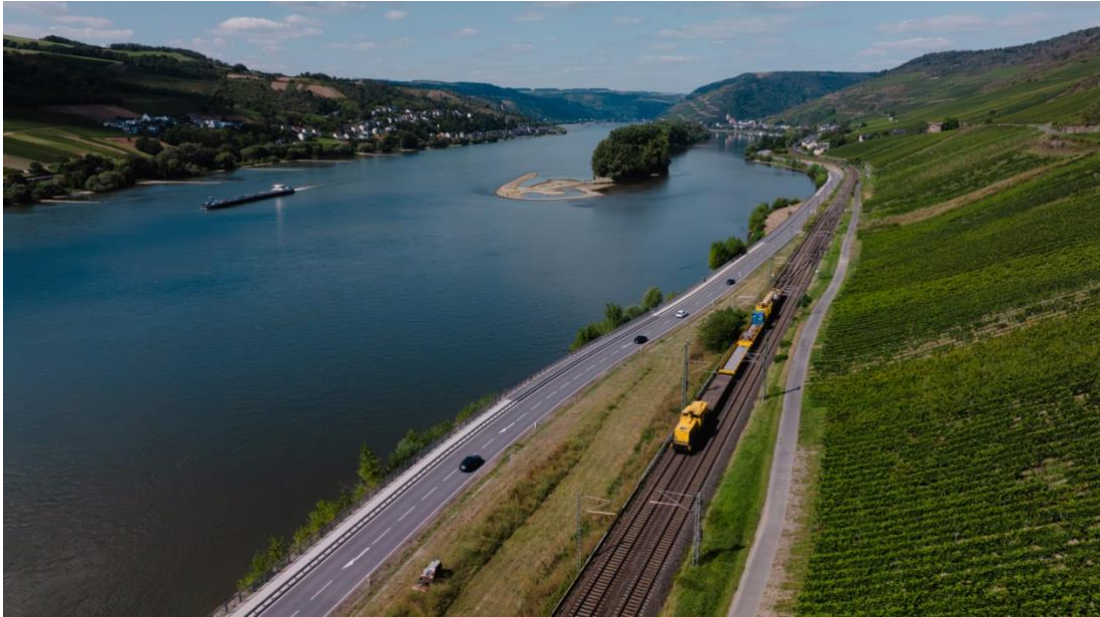
Die rechte Rheinstrecke wird zwischen Juli und Dezember 2026 saniert. Foto: DB AG
