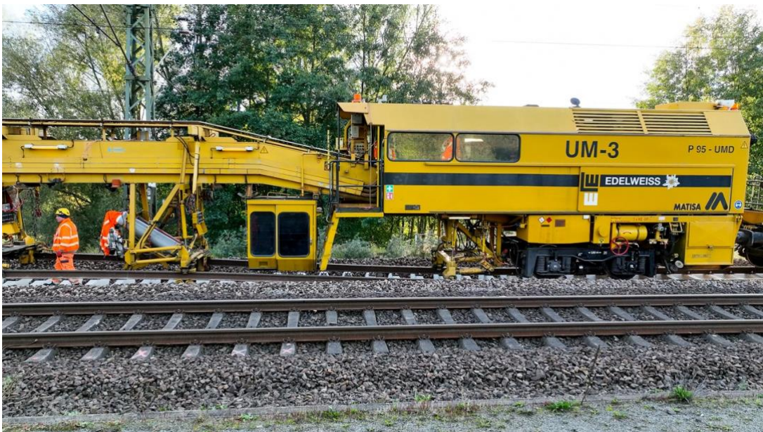
Nach den erfolgreichen Sanierungen der Riedbahn und des Korridors Hamburg-Berlin startet LEONHARD WEISS mit der Modernisierung der Abschnitte von Lahnstein über Neuwied bis nach Unkel. Foto: LEONHARD WEISS
