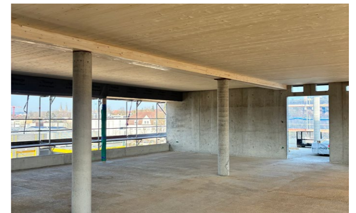
Büroerweiterung Göppingen – Mittelunterzug mit Dachdecke BSP Sichtqualität
