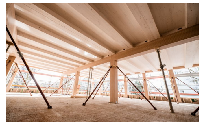
Bürogebäude TRI München – Geschossdecke und Stützenkonstruktion im Montagezustand
