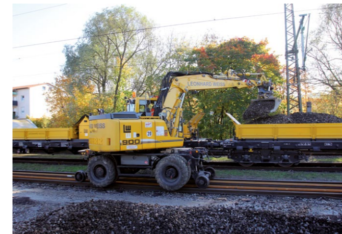
▲ Beladung mit Aushub unter Oberleitung
