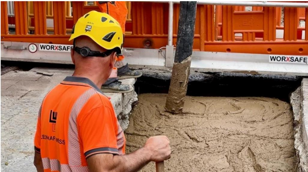
Foto 2: Der Flüssigboden wird in die Leitungsgräben verfüllt. Foto: LEONHARD WEISS
